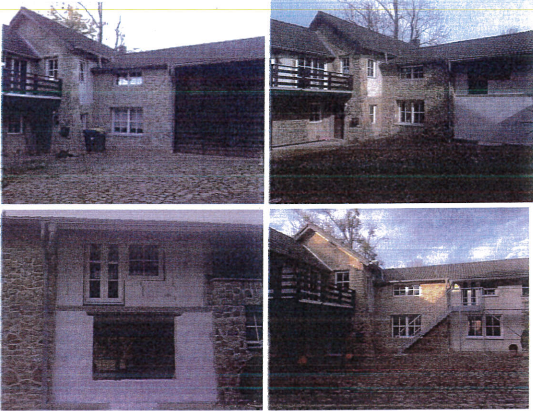
Gebäude von außen
