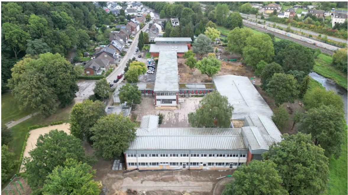
Abb. 4: Schrägaufnahme aus südwestlicher Richtung [August 2024, Quelle: Stadt Eschweiler]
