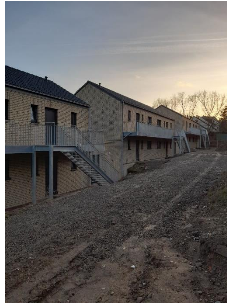
Abbildung 51: Bild Neubau Hüttenstraße 2. Bauabschnitt Rückseite
