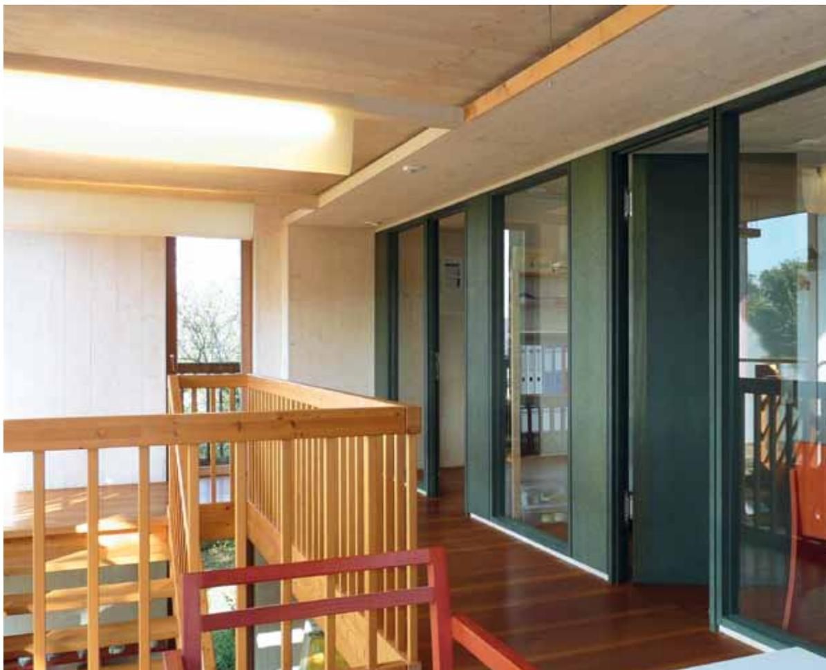
Die nur 33 cm dicken Außenwände mit einer Installationsebene sind mit Zelluloseflocken gedämmt. Die Innenseite der Wand ist mit einer doppelten Lage Gipskartonplatten beplankt. Von außen schützt entweder eine Faserzementplatte oder ein mineralischer Putz vor Witterungseinflüssen.
