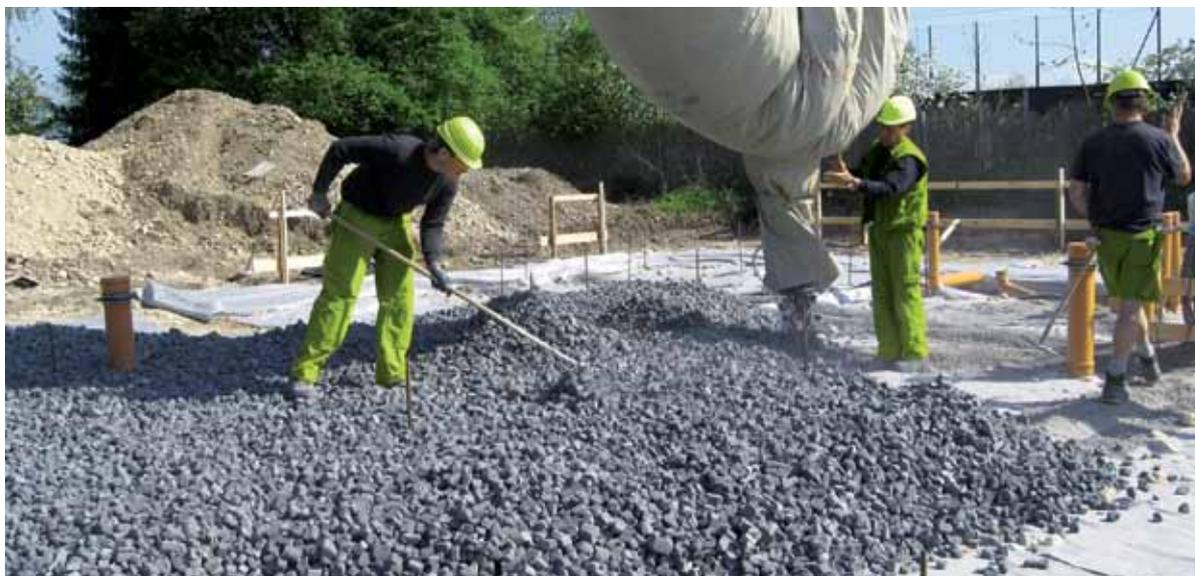
Abbildung 20: Mit Glasschaumschotter lassen sich lastabtragende Dämmungen herstellen, sodass gegebenenfalls auf ressourcenintensive Fundamentplatten verzichtet werden kann.
