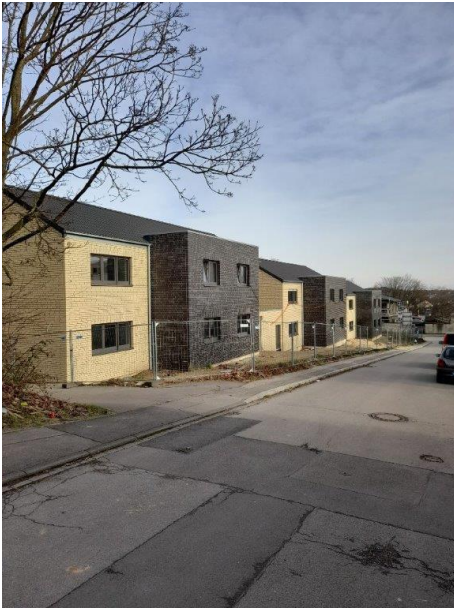
Abbildung 50: Bild Neubau Hüttenstraße 2. Bauabschnitt Front
