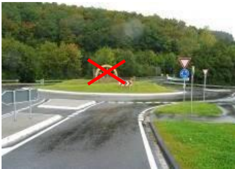
Bild 3 und 4: Zum Beispiel Bäume, Mauern, steile und hohe Einfassungen oder Aufschüttungen, Lichtmaste oder Kunstobjekte könnten bei einem Anprall durch ein Kraftfahrzeug zu schwerwiegenden Unfallfolgen führen.
