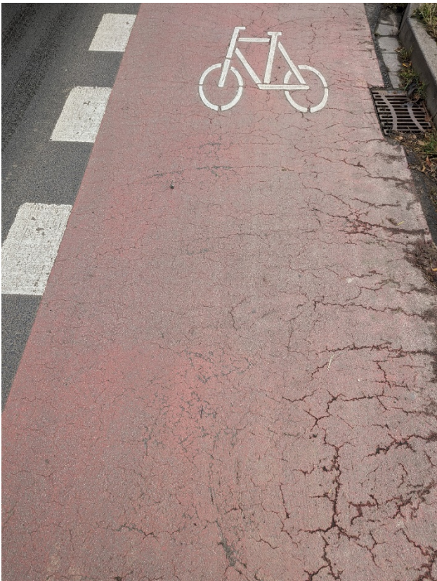
Abb. 4: Radfahrstreifen auf der L223-Dürener Straße, Nähe Einmündung Saarstraße
