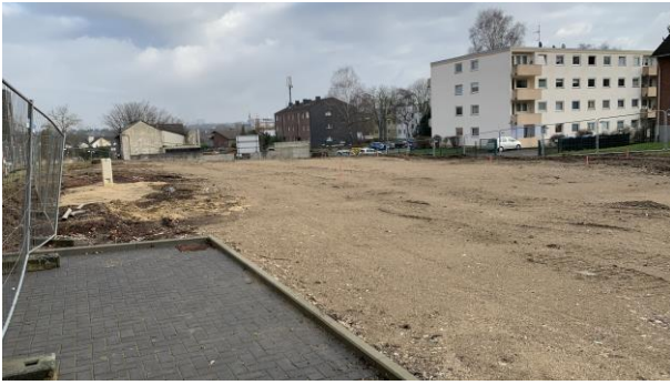
Abbildung 71: Bild Unterkunftsgebäude Hüttenstraße Abrissarbeiten 1
