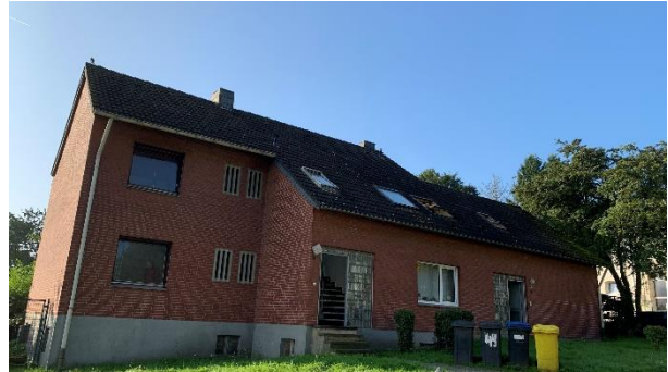
Abbildung 77: Bild Unterkunftsgebäude Hüttenstraße 28/30
