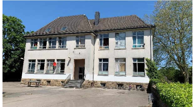
Abbildung 85: Bild Unterkunftsgebäude Severinstraße 14
