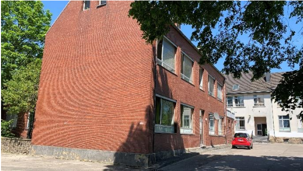
Abbildung 84: Bild Unterkunftsgebäude Severinstraße 12
