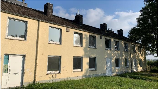
Abbildung 67: Bild 1 vorderer Gebäudeteil in der Hüttenstraße vor dem Abriss
