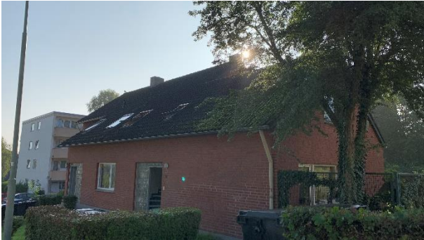
Abbildung 76: Bild Unterkunftsgebäude Hüttenstraße 28/30
