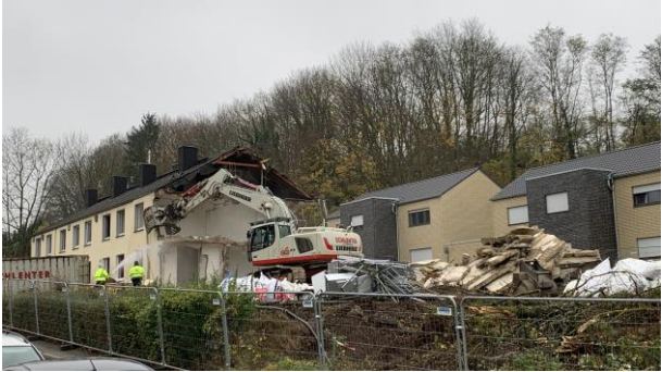
Abbildung 69: Bild Unterkunftsgebäude Hüttenstraße Abrissarbeiten 1
