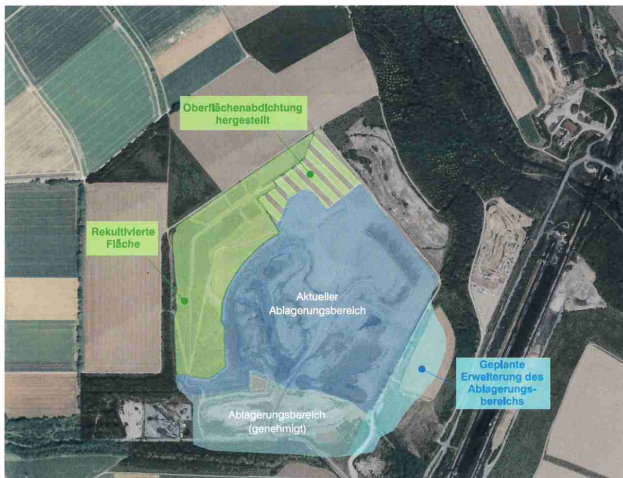
Abbildung 2: Ist-Stand Ablagerungsbereich mit geplanter Erweiterung des Ablagerungsbereichs (Befliegungsdatum 03.08.2020 © RWE Power)
