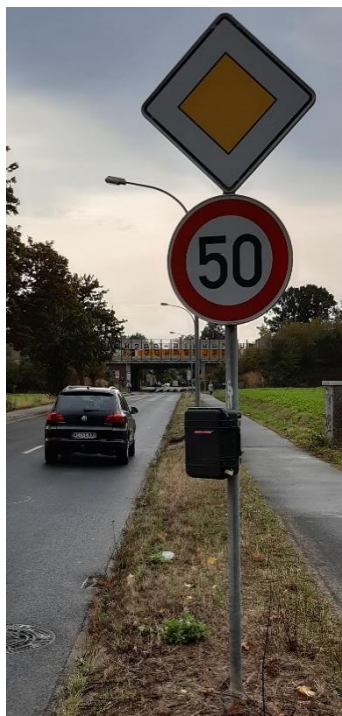
Abbildung 1: Befestigung des Radargerätes an der Jülicher Straße
