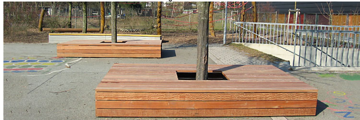
Die Bauscheiben auf dem Schulhof 3 werden in gemütliche Holzdecks umfunktioniert
