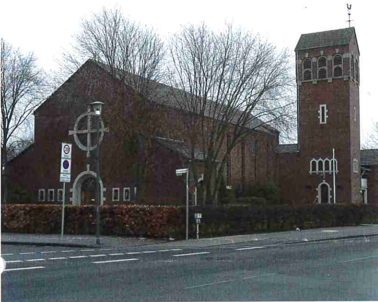
Ansicht von Südwesten (Aufnahme: 08.03.2016)
