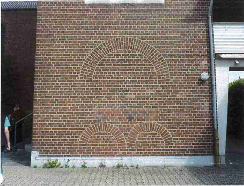
Turmschaft Detail Südseite
