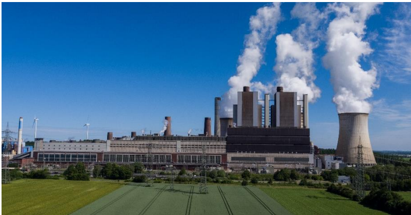
Abbildung 4: Kraftwerk Weisweiler (Quelle: Luftbildschrägaufnahme Opterix)
