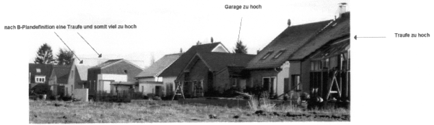
Traufe nach B-Plandefinition Schnittpunkt von Dach- und Wandfläche
