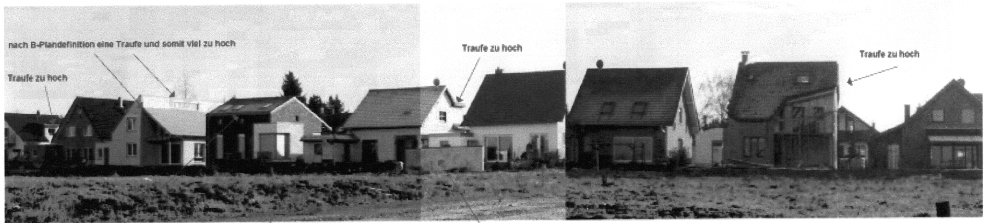
Traufe nach B-Plandefinition Schnittpunkt von Dach- und Wandfläche
