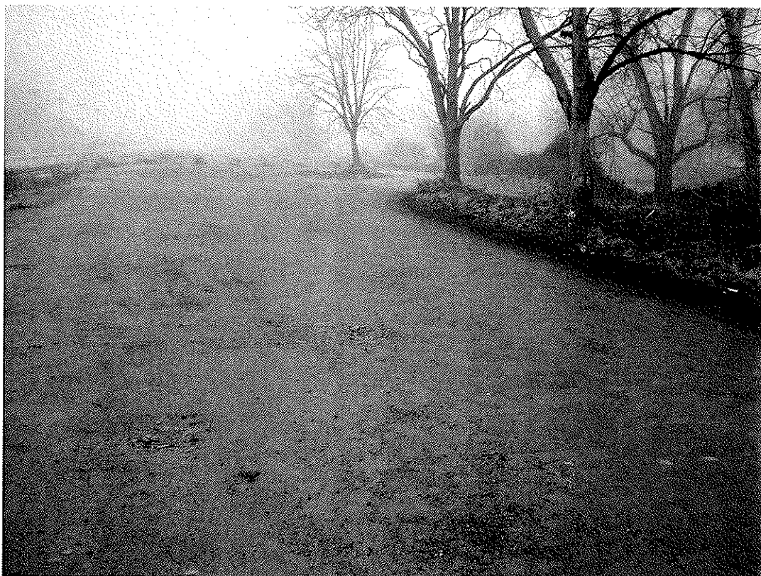
mit Natursteinpflaster und Schotter befestigte Parkplatzfläche
