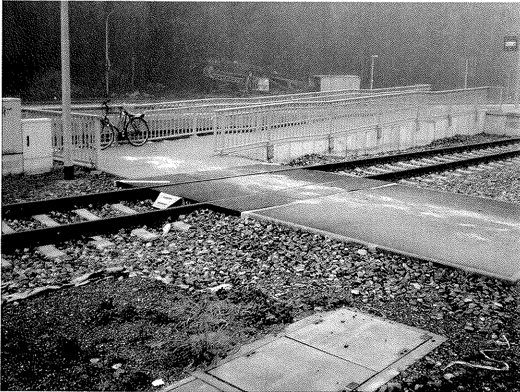
behindertengerechte Rampe am Bahnsteig
