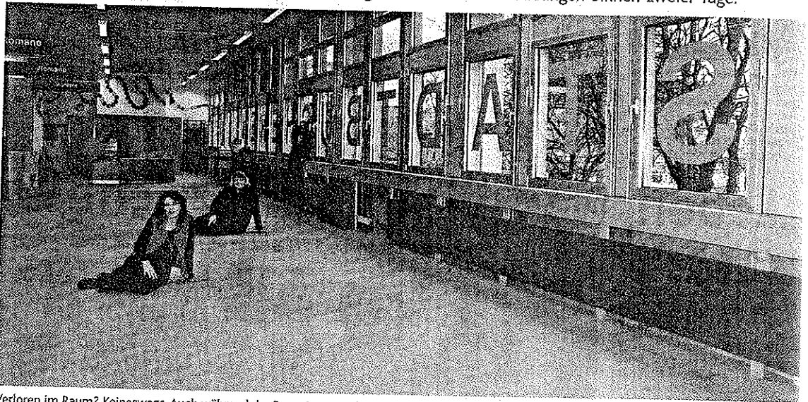
Verloren im Raum? Keineswegs. Auch während der Renovierungsarbeiten gibt es für die Mitarbeiterinnen der Bücherei – hier Ingrid Nicoletzki, Danja Moritz und Yvonne Huwer – genug zu tun. Foto: Michael Cremer
